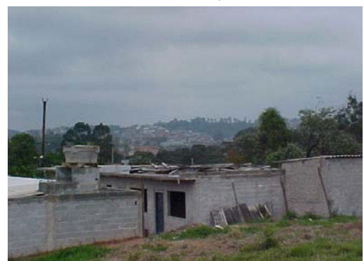
12. Loteamento irregular se expandindo entre a mata. Jd. Noronha
