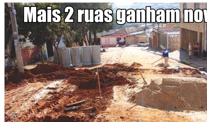
Rua Gomes: ampliação de galeria vai evitar alagamento
